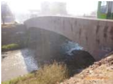
Foto N° 5. Puente Existente salida
