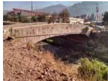
Foto N° 6. Puente existente entrada
