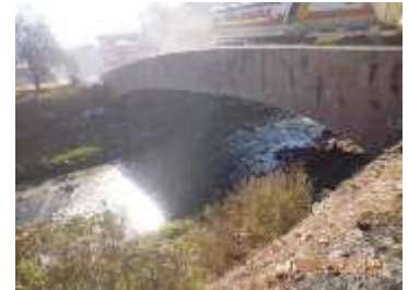
Foto N° 9. Tercer Cruce Km 6+874.399
