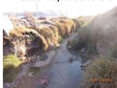
Foto N° 11. Sección a tajo abierto del canal central
