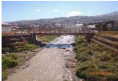
Foto N° 7. Primer Cruce Km 4+380
