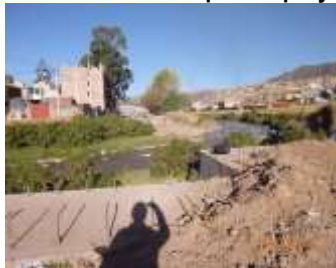
Foto N° 3. Ubicación del puente proyectado
