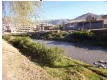
Foto N° 8. Segundo Cruce Km 6+180
