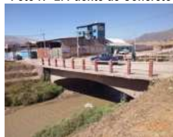
Foto N° 2. Puente de Concreto
